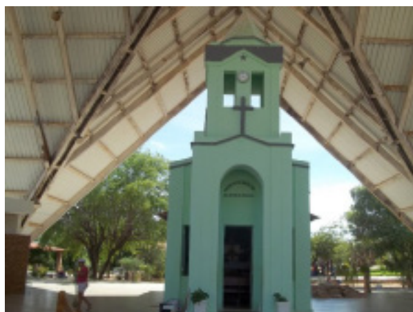
Imagem 3: Lado externo da Capela Santa Francisca. Foto: Robéria Nádia
